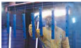
Полуавтоматическая порошковая окраска поверхностей
